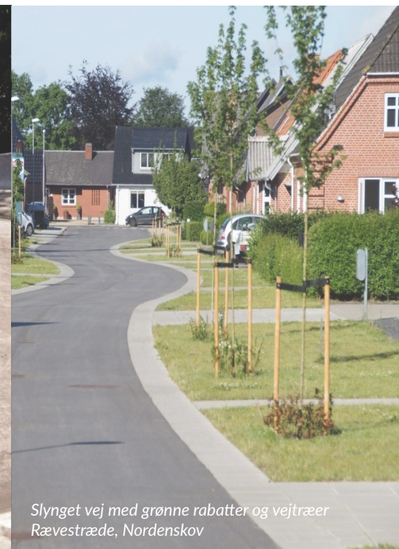
Skaterbane, som er regnvandsbassin under skybrud Remiseparken, København
